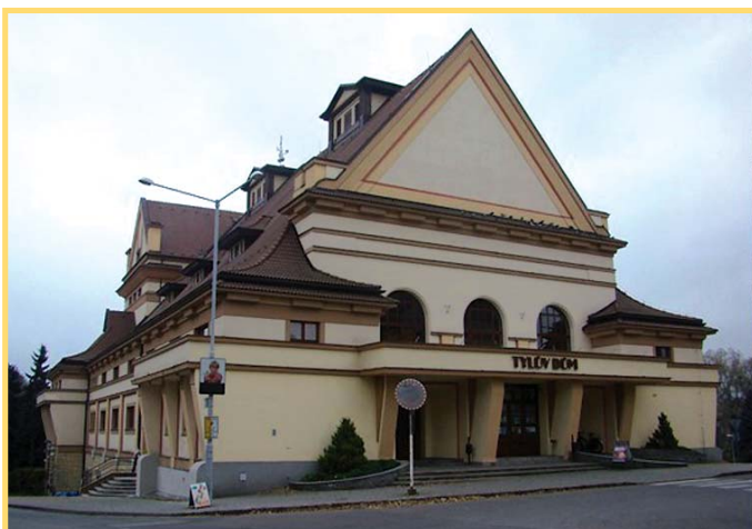
Tylův dům v Poličce – pohled z průčelí, foto 2013
