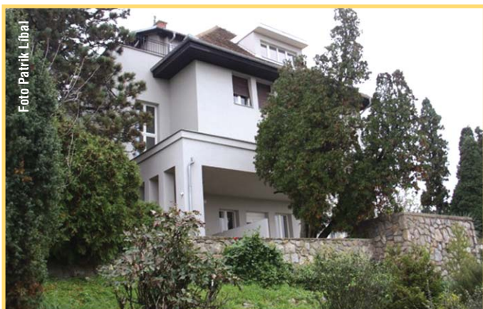
Výstavní vila – kolaudovaná jako rodinný dům v roce 1930 pro rodinu ředitele Adolfa Hlaváčka v Nosislavi
